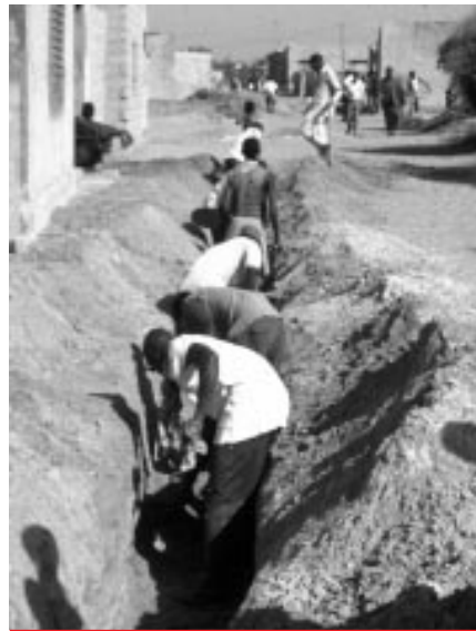
ENSEMBLE POUR PROLONGER LE RÉSEAU D'ADDUCTION D'EAU (Photo UNESCO).
